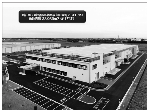
写真2 新設のクリーン工場
