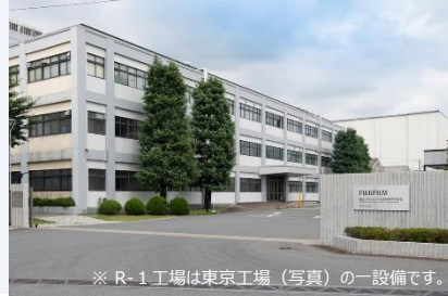
東京R-1工場 (埼玉県川越市)
